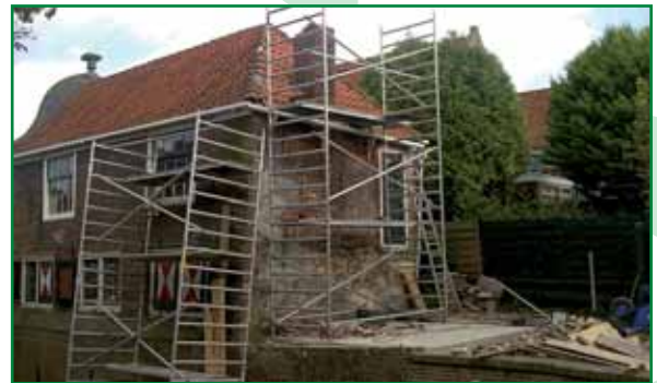
Het monumentale pandje Zuideinde 2 in Monnickendam
